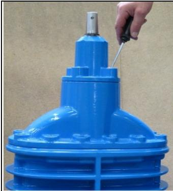
1. Wachsversiegelung der Zentrierflanschverschraubung entfernen.
